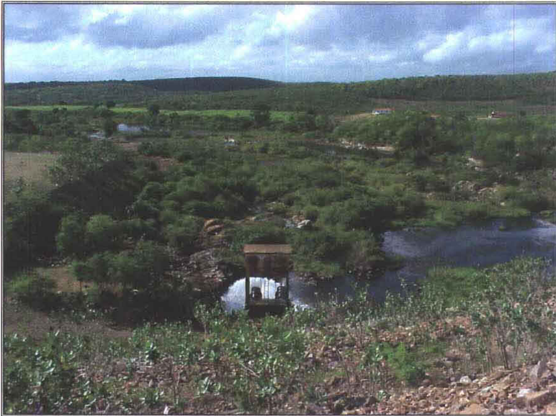
Figura 5 – Vista das Válvulas a Partir do Coroamento do Açude
